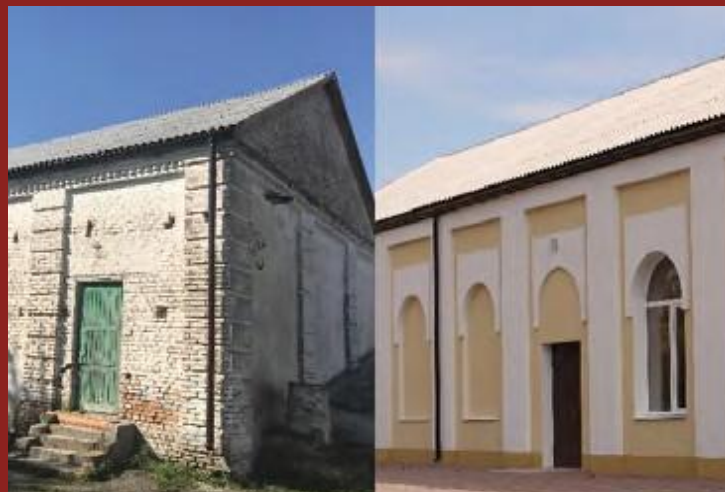
Зовнішнє утеплення будинку культури Новогалещинської ОТГ
